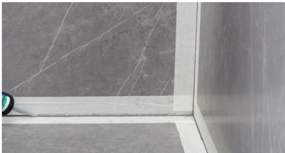
Giunto perimetrale sigillato con MAPESIL AC
