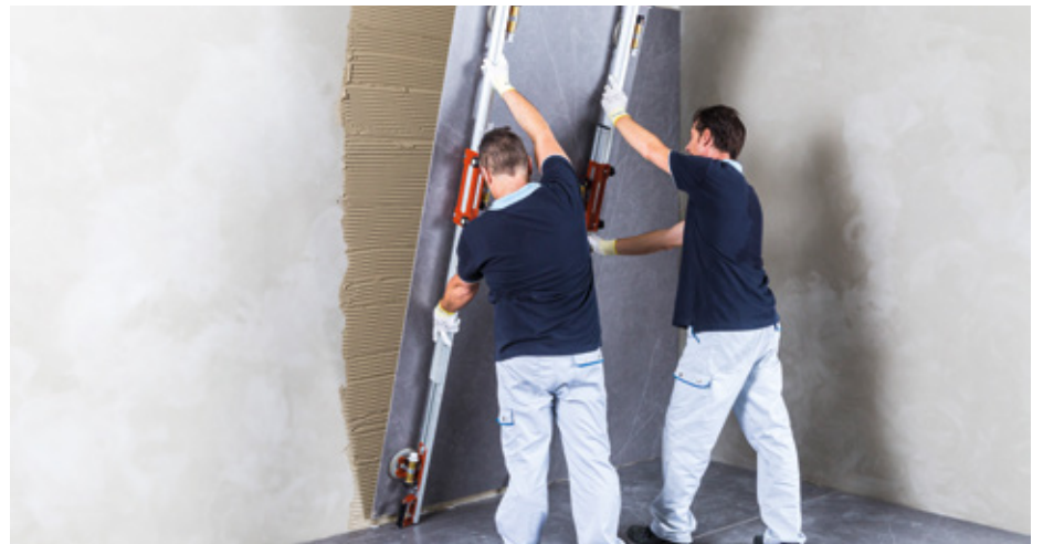
Posa lastra a parete
