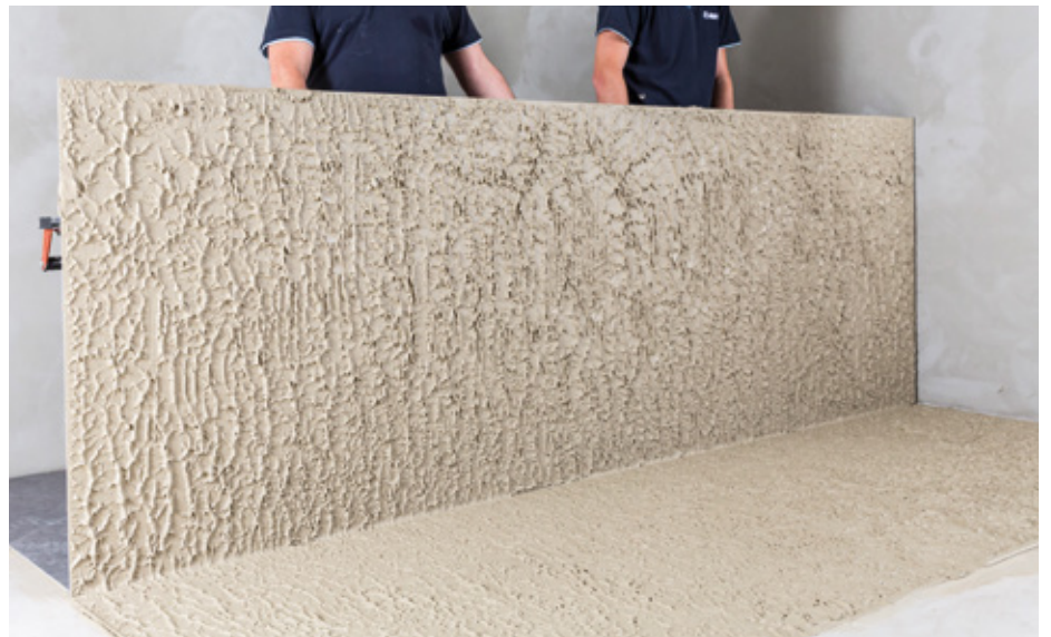
Scelta di un adesivo ad elevata bagnatura del retro lastra
