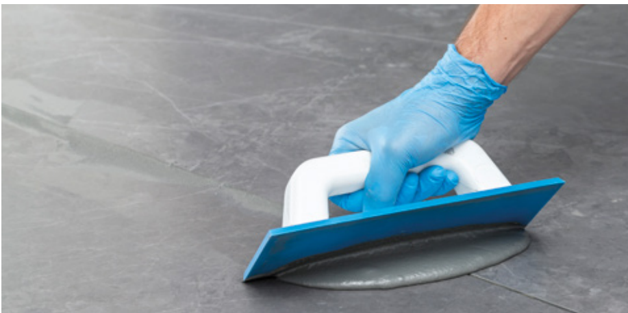
Stuccatura delle fughe
