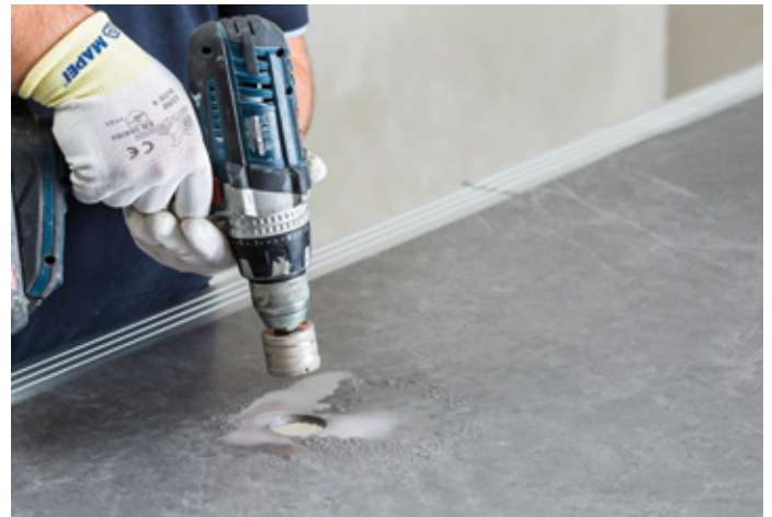
Sequenza per eseguire fori circolari
