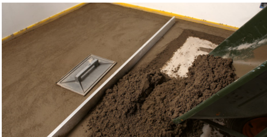
Realizzazione di massetto con TOPCEM PRONTO
