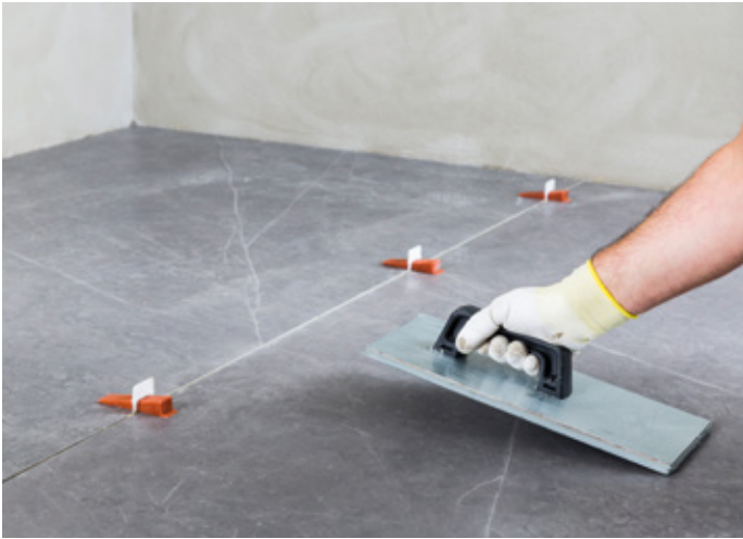
Battitura della lastra manuale o con macchina vibrante
