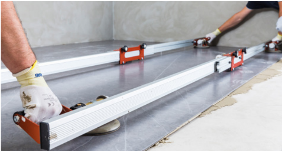
Posa della lastra
