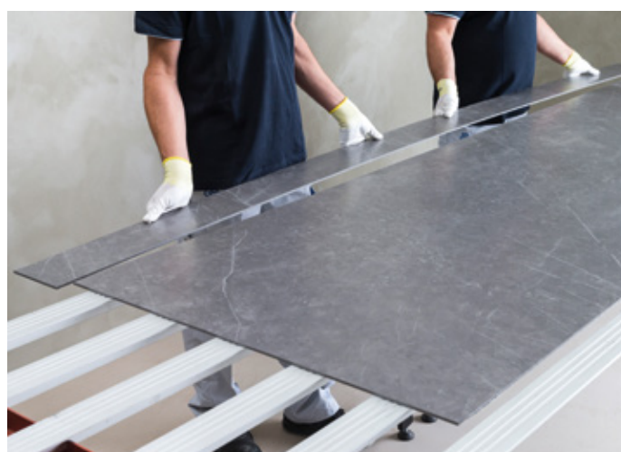
Rottura a spacco della lastra
