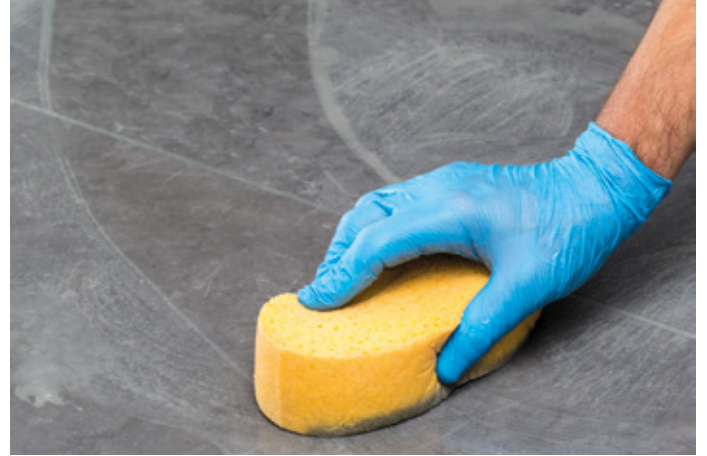
Pulizia della fuga con Scotch-Brite e infine con spugna
