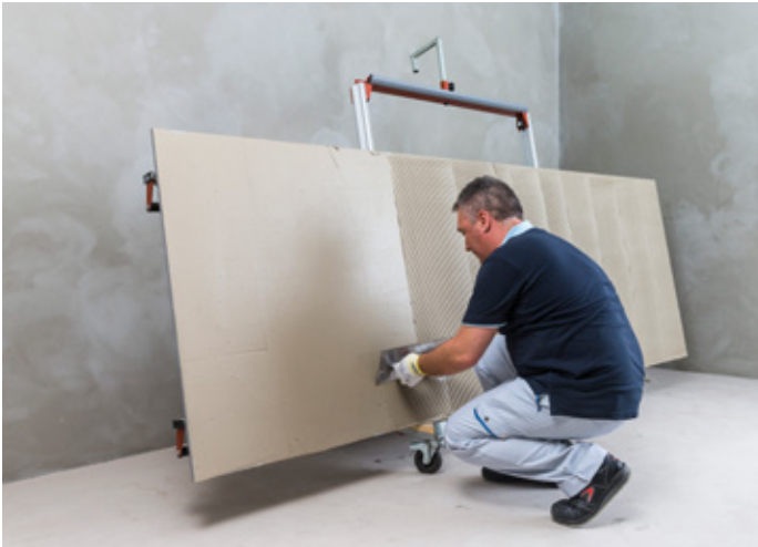
Stessa direzione di spalmatura dell'adesivo sul retro lastra e sul supporto
