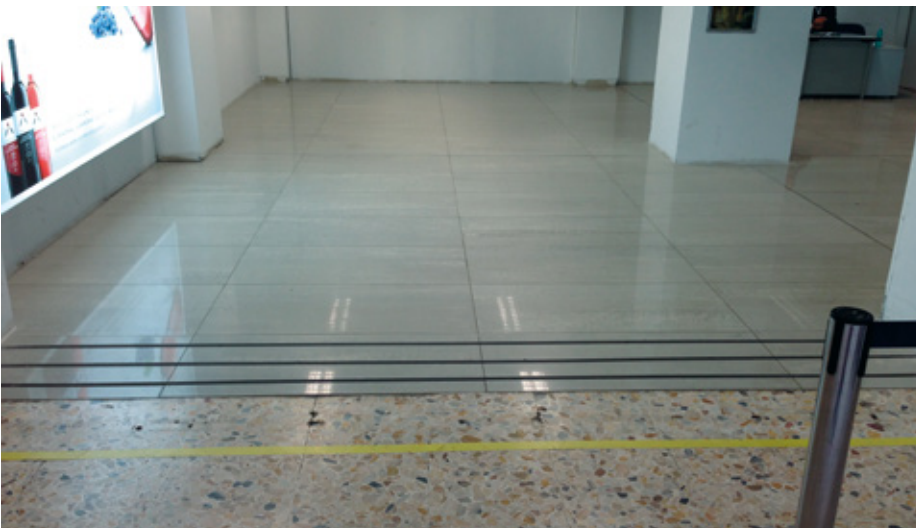
Posa su pavimentazione esistente
