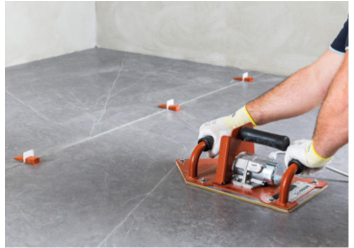
Battitura della lastra manuale o con macchina vibrante
