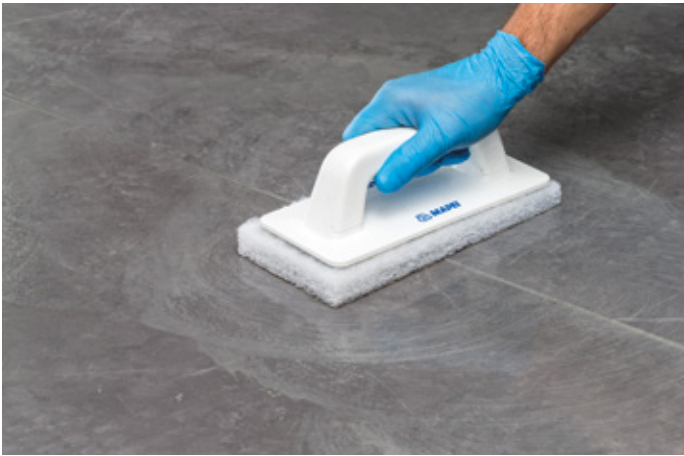
Pulizia della fuga con Scotch-Brite e infine con spugna
