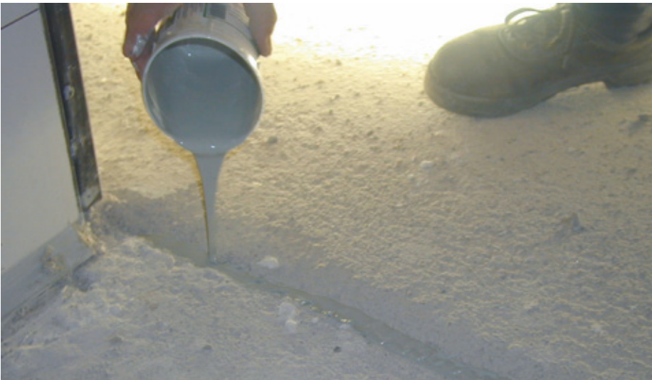
Sigillatura di fessure del sottofondo con EPORIP
