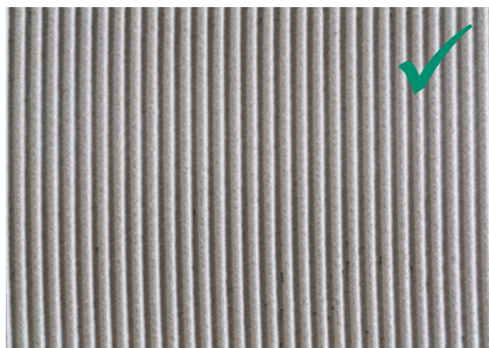
Esecuzione della corretta spalmatura dell'adesivo
