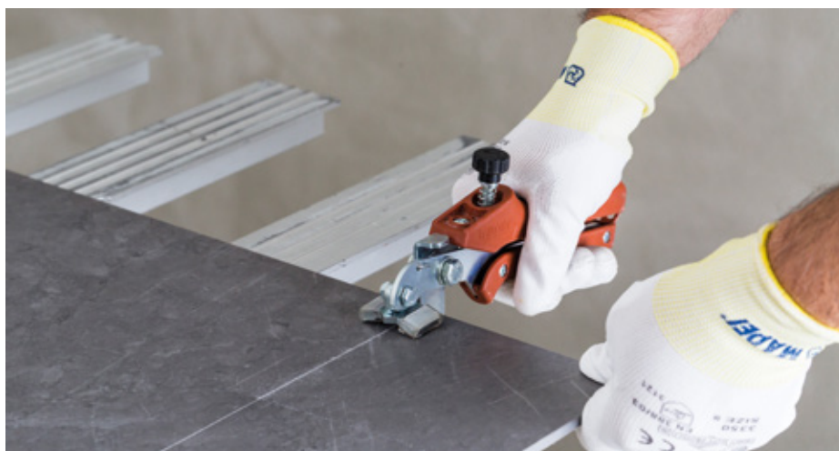
Creazione della cricca tramite pinza troncatrice
