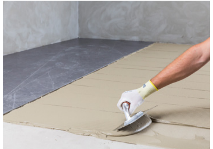
Stessa direzione di spalmatura dell'adesivo sul retro lastra e sul supporto
