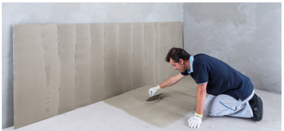
Posa di lastra con tecnica della doppia spalmatura
