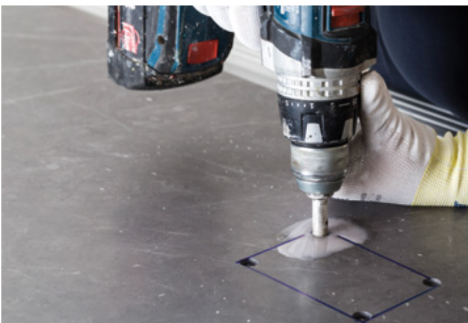
Sequenza per eseguire fori rettangolari
